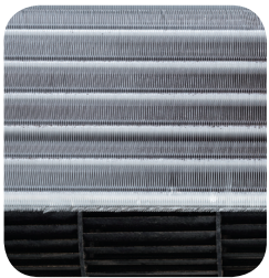
Sisäyksikön lämmönsiirrin 10 vuoden jälkeen ilman pinnoitusta.
